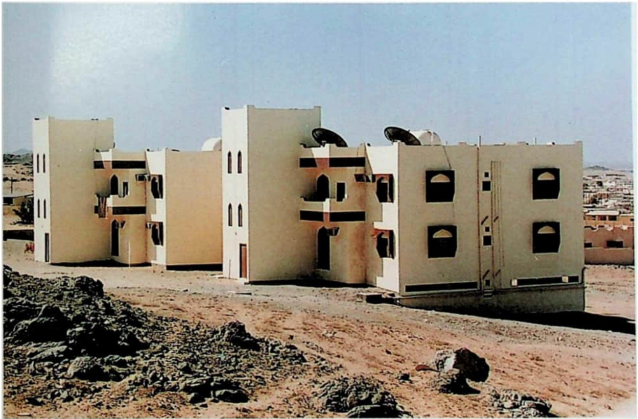
أحد المباني الحديثة - رأس حلف
