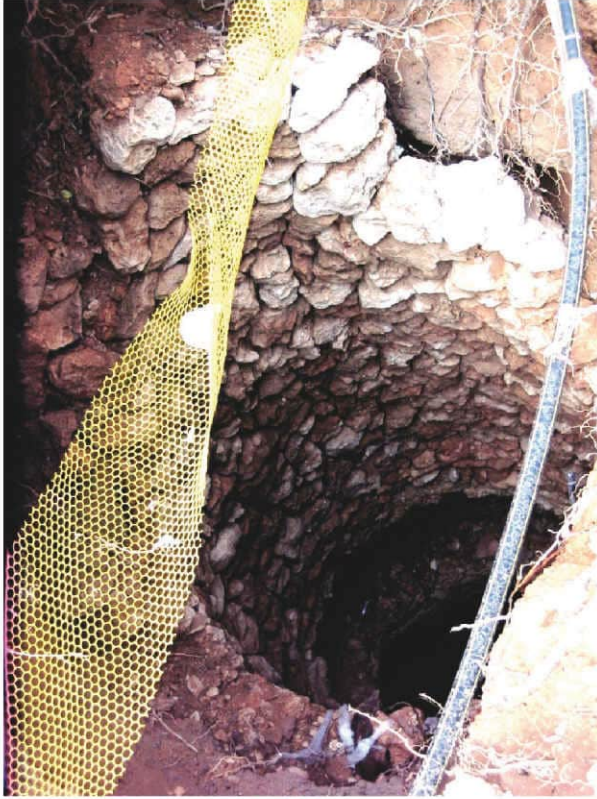
إنفصال موضعي للحجارة المكونة لجدار الربط
