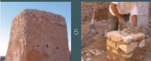
5 - استعمال الملاط في أشغال البناء
