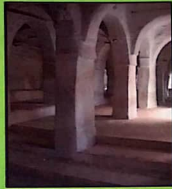
الصورة 35: منظر يوضّح لاختلاف المستويات الأرضية داخل بيت الصلاة (مسجد غرداية الصنّيق)
