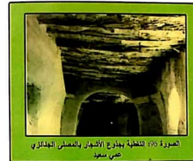
الصورة 95: تغطية التغطية بجذوع الأشجار بمسجد غرداية
