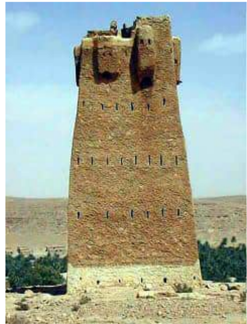
اللوحة 78 : برج زليقة الفوقاني، الواجهة الغربية.
