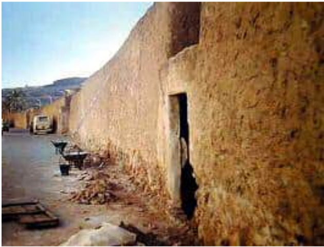
اللوحة 56 : الطبانات أثناء عملية الترميم.
