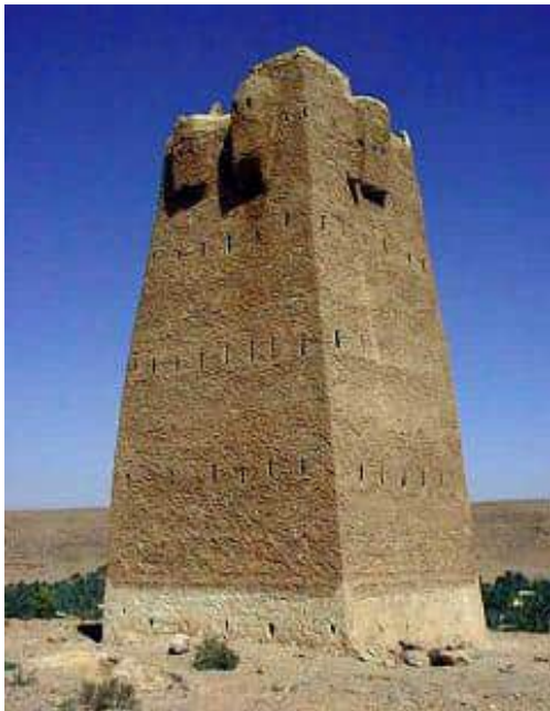
اللوحة 80 : برج زليقة الفوقاني، الواجهة الغربية.
