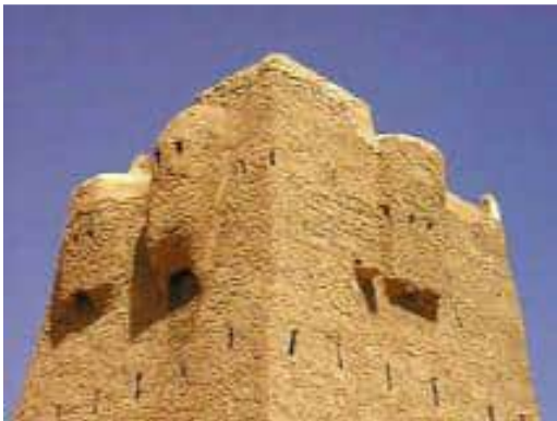
اللوحة 86 : عنصر السقطة، والميزاب الذي في شكل صفيحة من الحجر الجيري.
