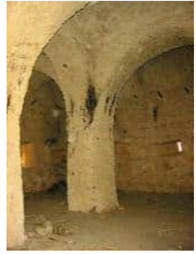
اللوحة 81 : الدعامات والعقود الحاملة لأقباء السقف.
