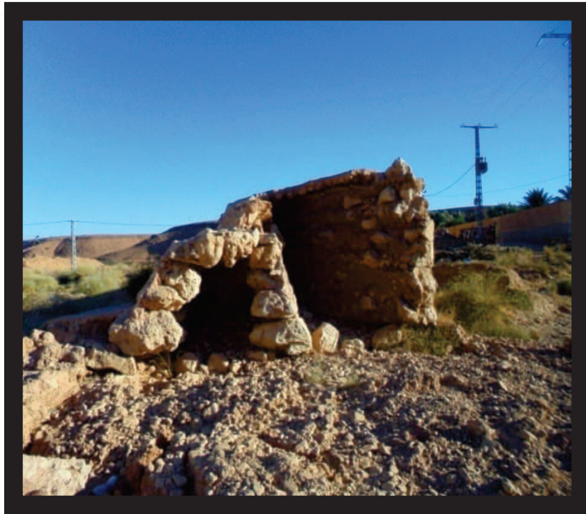
الصورة 39 تقنية بناء السدود
