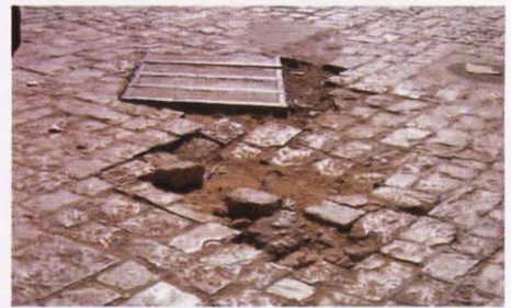
تدهور التبليط بسبب تسربات داخلية
