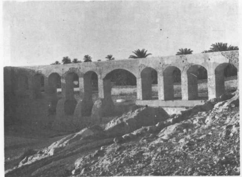
منظر لسد مليكة يحجز مياه وادى مزاب
